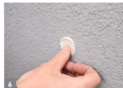
6 Jetzt den Capatect Gerüstankerstopfen in das Gerüstankerloch einführen, bis die Kappe bündig mit der Putzoberfläche sitzt. Am Rand austretende Capatect Fugenmasse MS einfach abstreichen und somit einen abschließenden Rand bilden.
