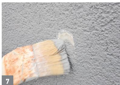
7 Nach Expansion des Dichtstoffes und Durchtrocknung der Capatect Fugenmasse MS den Capatect Gerüstankerstopfen mit einer entsprechenden Fassadenfarbe überstreichen.
