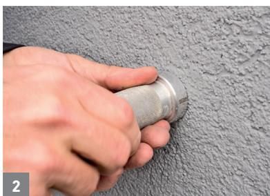
2 Fräser in das Gerüstankerloch einführen, fest andrücken und drehen, bis eine gleichmäßige Vertiefung von 3 – 4 mm entstanden ist.
