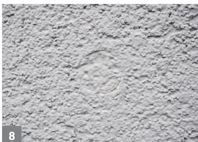
8 Als Endergebnis entsteht eine Oberfläche mit putzähnlicher Struktur. (für glatte Oberflächen bitte den Stopfen abschleifen)
