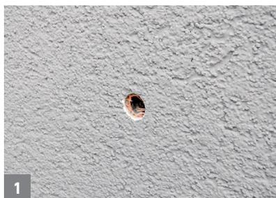
1 Gerüstanker aus dem Loch entfernen und dieses reinigen.
