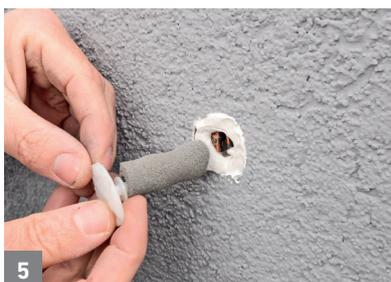
5 Den am Capatect Gerüstankerstopfen befindlichen imprägnierten Weichschaumstoff durch Rollen und Drücken mit der Hand auf unter 12 mm komprimieren.
